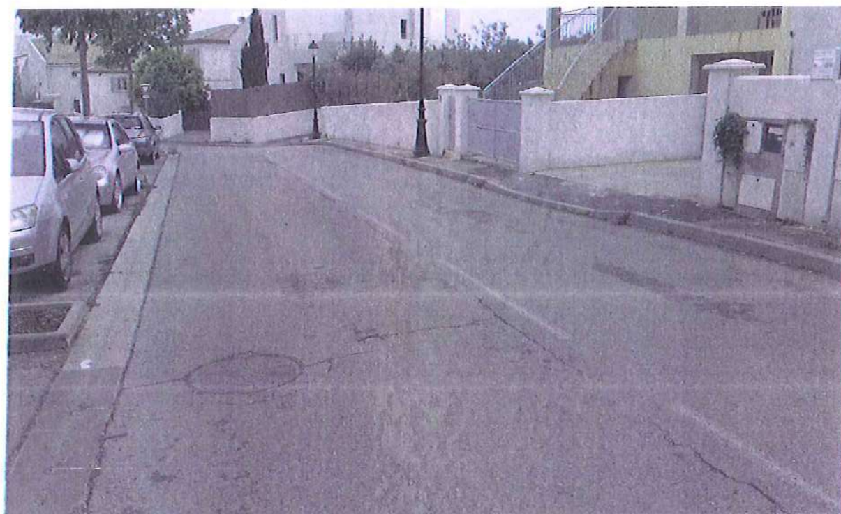
Rue de Fondespierre (reprise fissures sur chaussée (emulsion + sablage))
