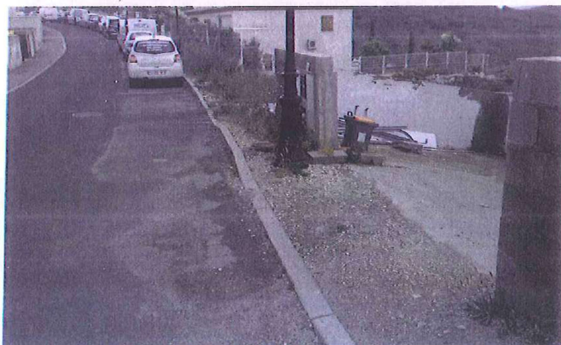
Rue de la Circulade (n°56 et 58). Reprise trottoir complet + bordures.
