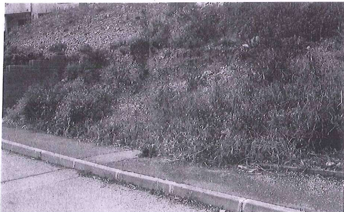
Rue de l'ombrée (passage dans talus) Muret de soutènement à faire.
