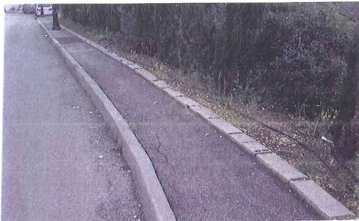
Rue Fondespierre (devant portail n°1 Erilla)(trottoir fissuré et afaissé à reprendre)
