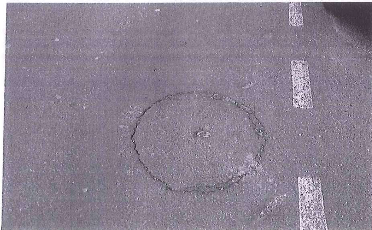
Rue de la Circulade (mise à la côte des tampons)
