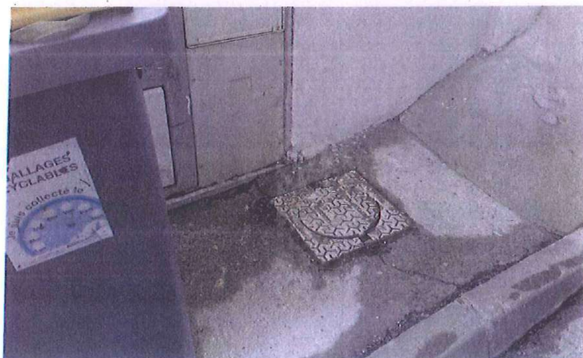
Rue de la Circulade (mise à la côte boîte de branchement)
