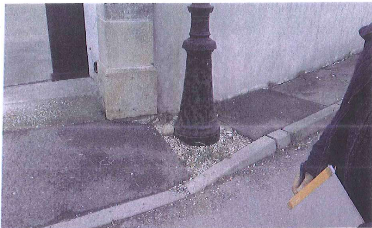
Rue de la Circulade n°2 (reprise enrobé en pied de candélabre)
