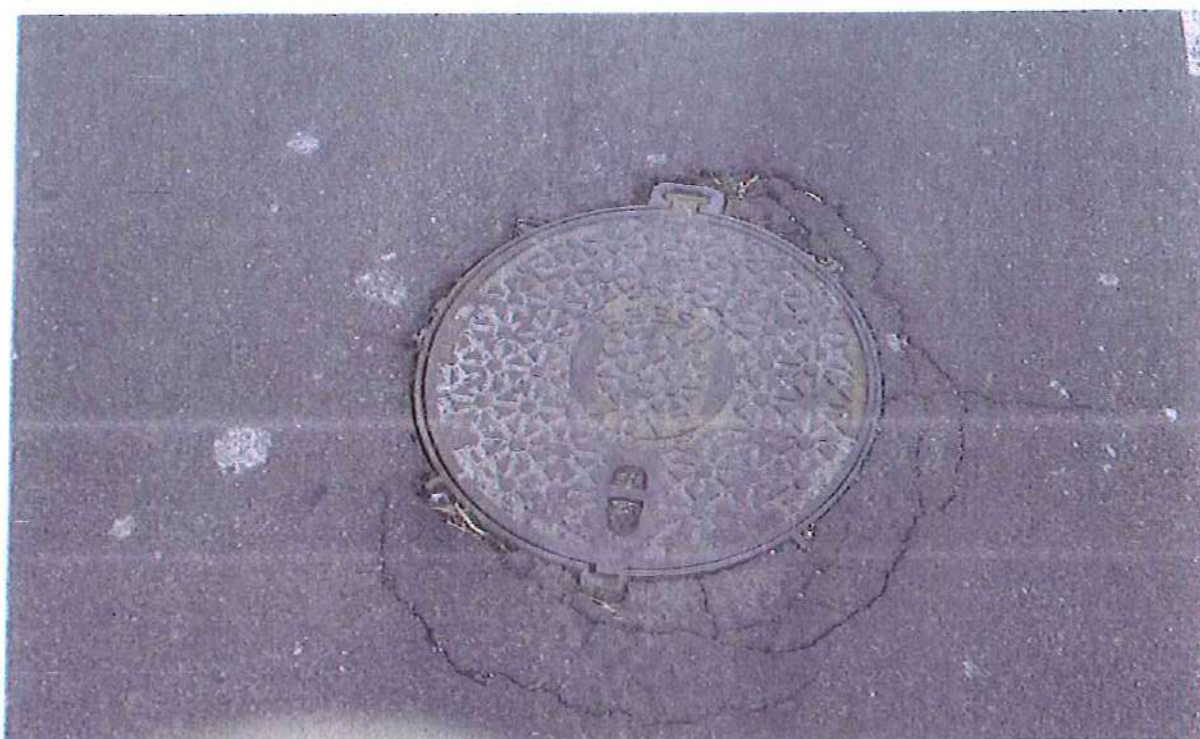
Rue de la Circulade (scellement tampon)
