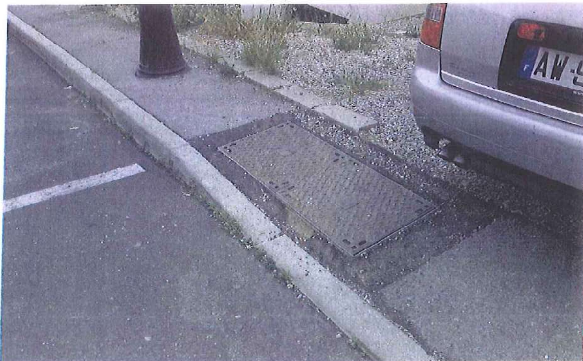
Rue de la Circulade (n°54). Mise à la cote regard France Télécom
