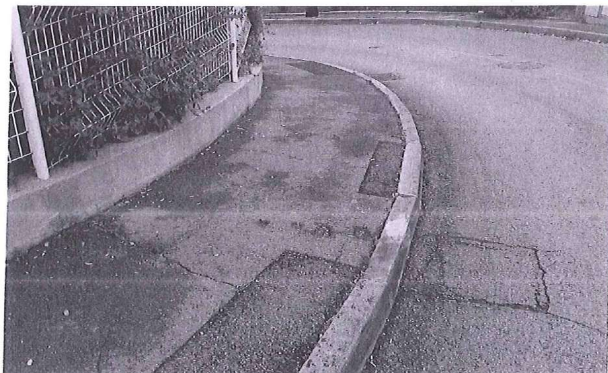
Rue Fondespierre virage Erilla (reprise enrobé sur totalité surface)
